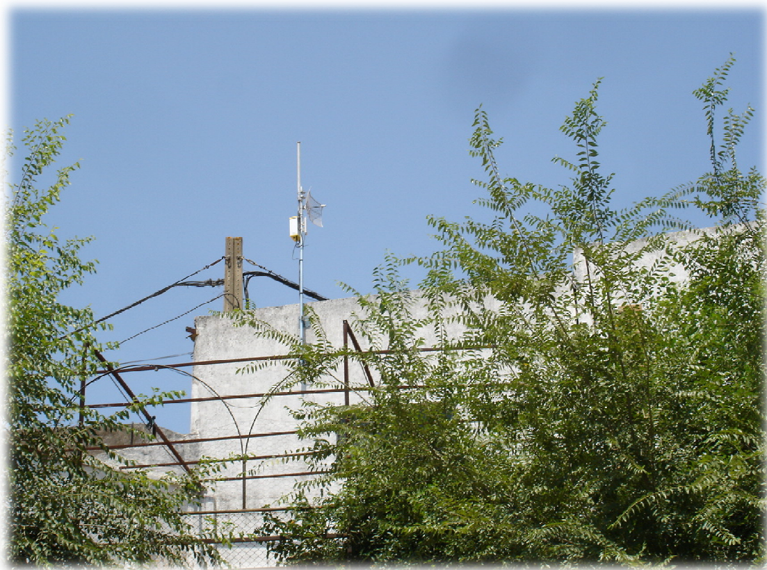
Figura 9: Antena de datos al "Silo del Cereal".
