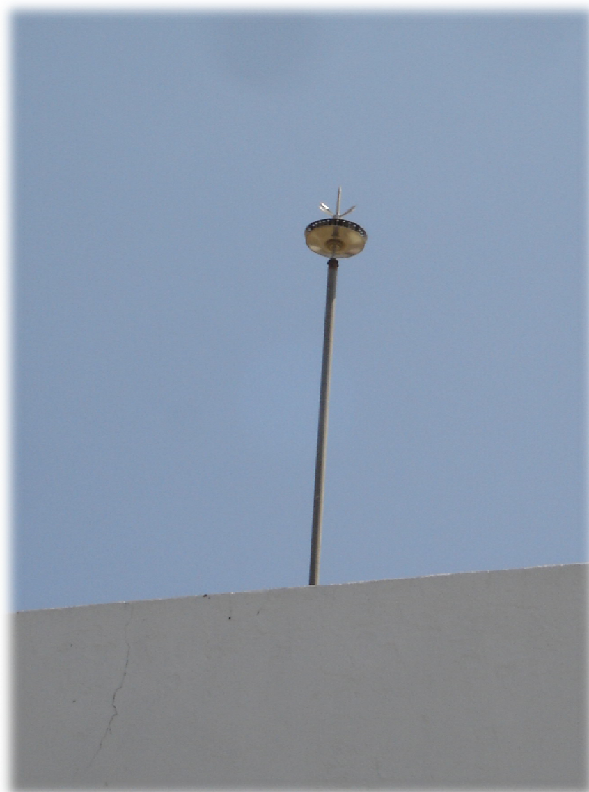
Figura 11: Pararrayos del I.E.S. Lucas Solis. Fuente: Elaboración propia.
