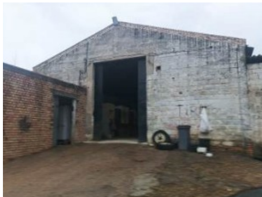
Imagen 8: Nave principal (Documento de valoración aportado en la alegación). Nave sin uso cerrada
